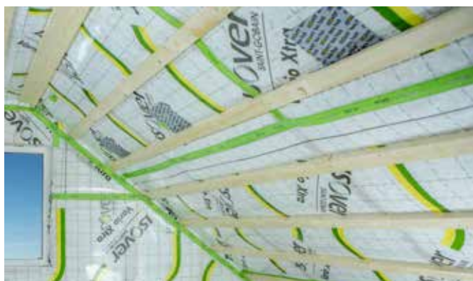
2.9 Lufttätskikt med ISOVER Vario® Xtra och korslagda regler.
