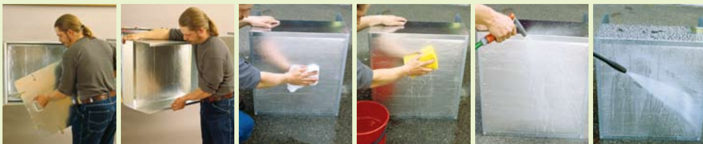
Öppning av inspektionslucka.
