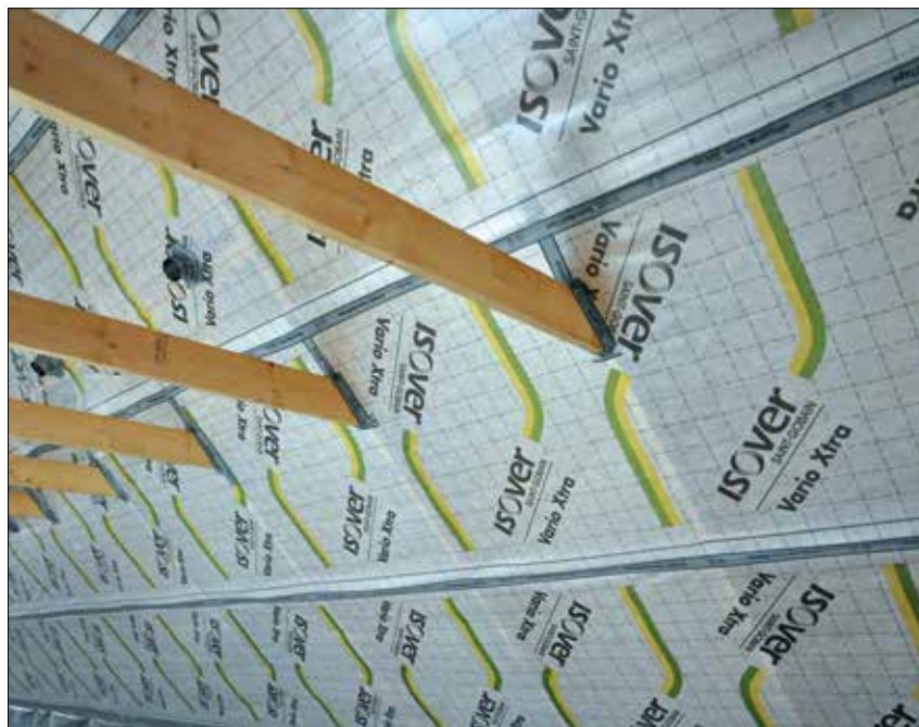
ISOVER Vario® Xtra monteras i snedstak, därefter monteras korsreglar för installationsskikt.
