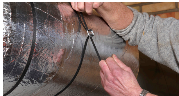
Bandning med minst tre band per mantellängd.
