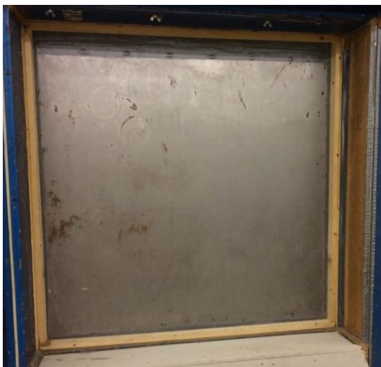
Bild 2 – Sändarrummet (insida), drevsystem 6. Träbeklädnad som motsvarar foderlister (eller annan väggbeklädnad/skivmaterial).
