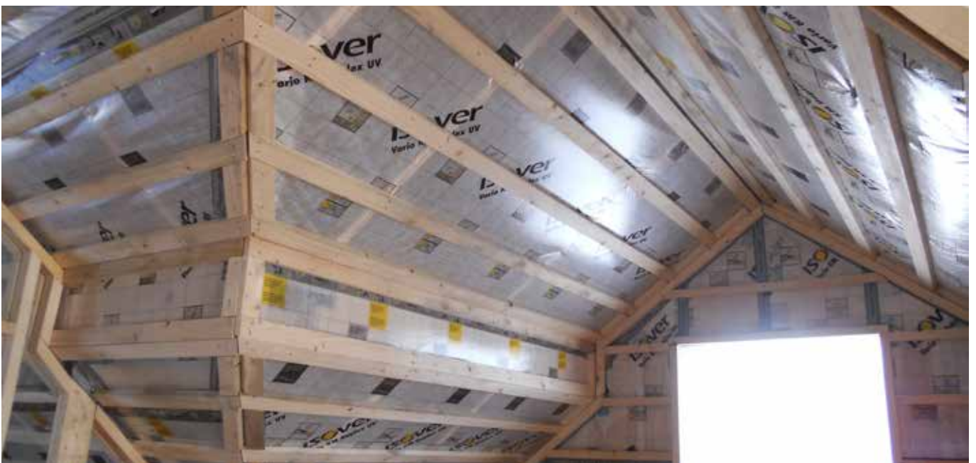
Lufttätning och ångbroms med ISOVER Vario Xtra.
