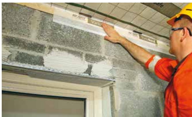
Anslutningar mellan träregelverk och betongmaterial
