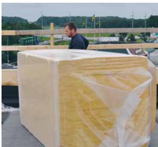
Lägg förpackningen på sidan så att lamellerna ligger rätt för hantering.
