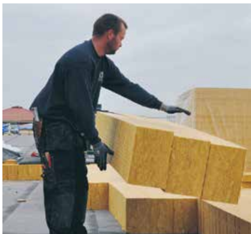
Lägg ut lamellerna på underlaget och rätta till så lamellerna ligger korrekt.
