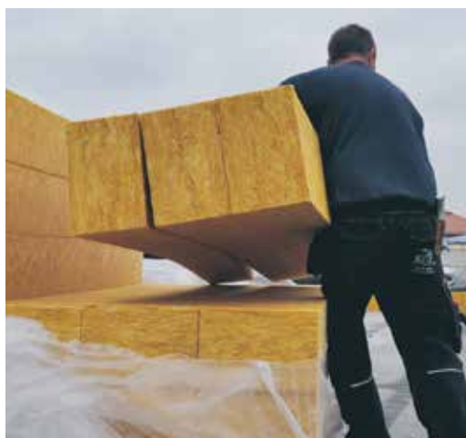
Ta upp till tre lameller i ett grepp.
