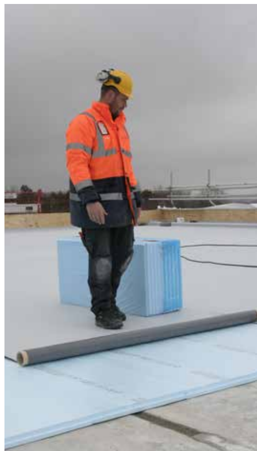
Montage av tätskikt på första isoleringsskikt i duotak.
