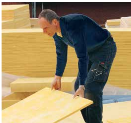
ISOVER Takboard 33 placeras överst som ett lastfördelande skikt.
